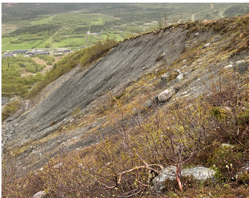
Figur 6. Pågående erosion i den västra slänten i västra ravinfåran.
