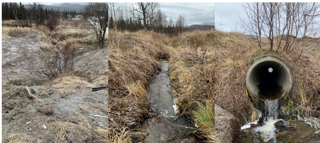
Figur 8 till vänster. Dike vid utlopp från D1000-trumma (T1).
