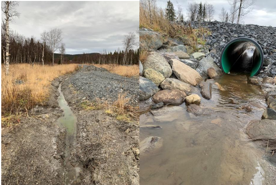
Figur 20 till vänster. Nylagt dike längs södra gränsen av planområdet.
