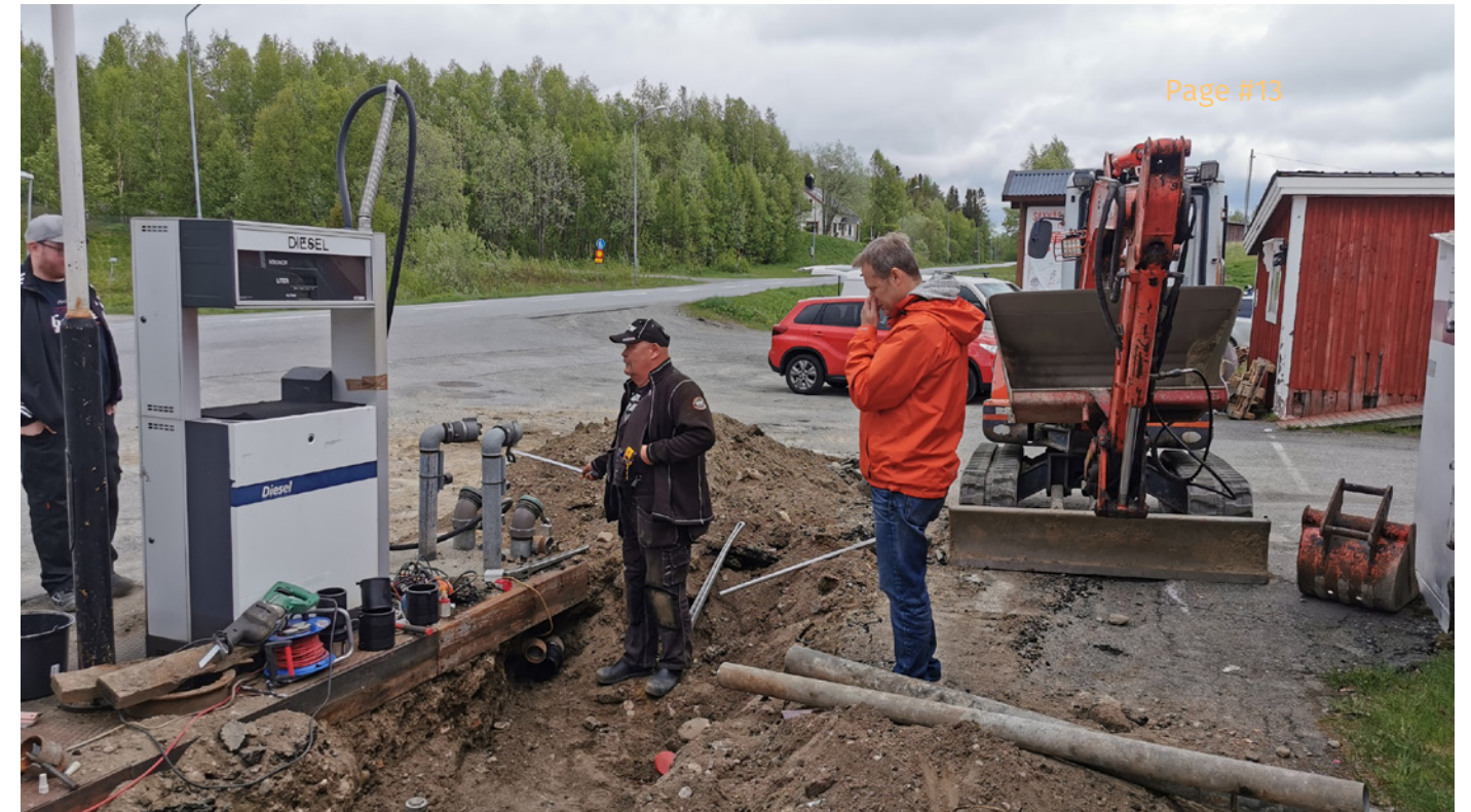
Nu är arbetet med att rostskyddssäkra rören på drivmedelsanläggningen hos Marsfjällshandlarn i Saxnäs påbörjat. På bilden ser ni Glenn Sjöberg från Öviks Pump & Miljö AB och Peter Manner, näringslivskontoret i Vilhelmina
