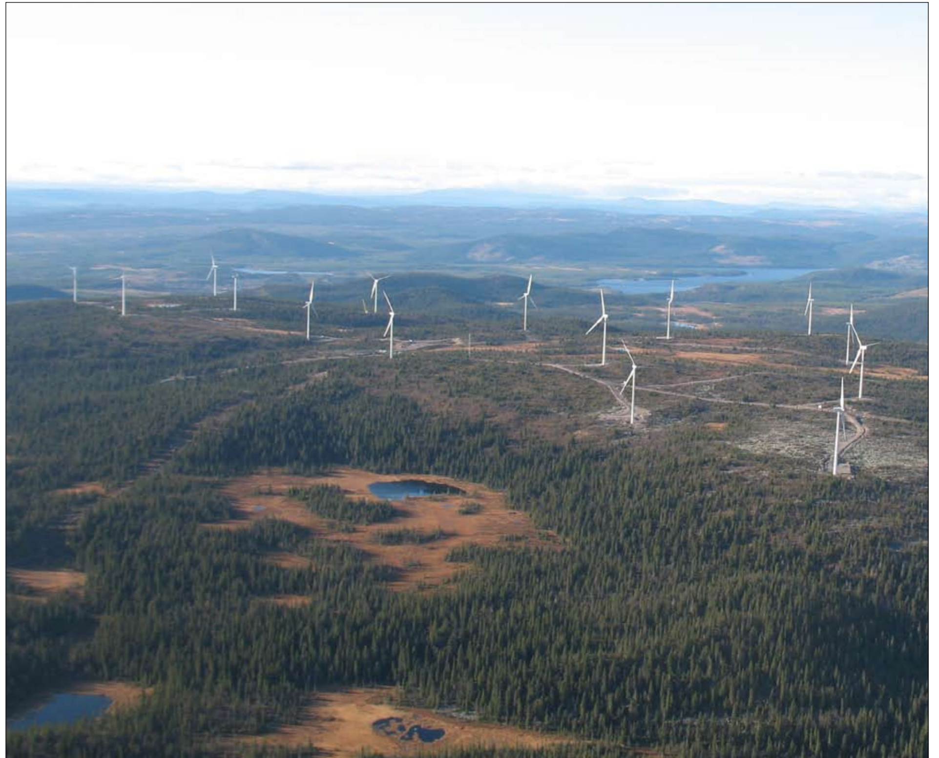
15 av 18 verk i vindkraftparken på Bliekevare, i Dorotea kommun. Uppförda av o2 Vindkompaniet AB.
