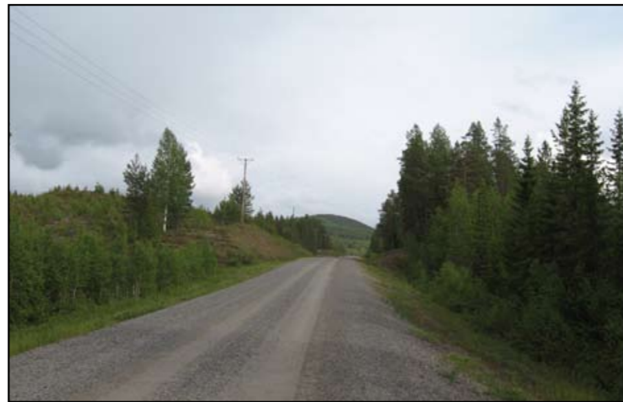
Fig 4.1:5 Utblick mot Granliden.
