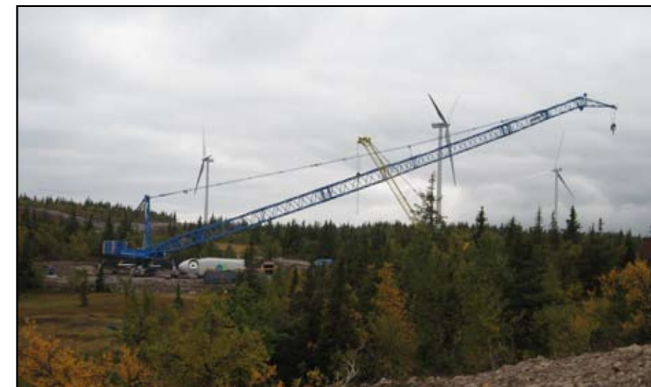
Kran som används vid monteringen av vindkraftverken på Bliekevare, i Dorotea kommun.
