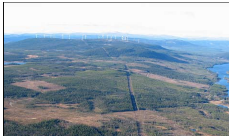
Hela vindkraftanläggningen på Bliekevare, i Dorotea kommun, med transformatorstationen i förgrunden.
